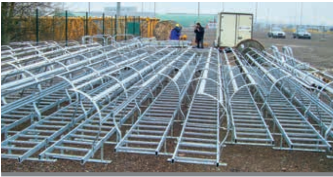
Egyszakaszos rögzített létrarendszer telepítése. Hátvédőkengyellel előszerelt létrák telepítés előtt.
