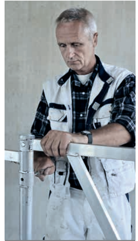
3. lépés: Az alapkeretet rögzítse a rugós biztosítóval.
