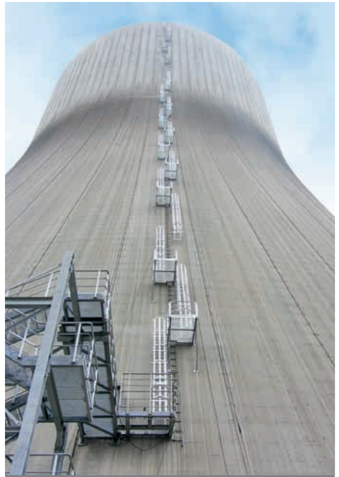
Rögzített létrarendszer egy hűtőtornyon.
