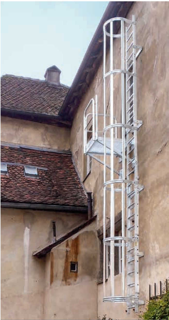
Egyszakaszos rögzített létrarendszer vészkijáráshoz rögzített dobogóval.
