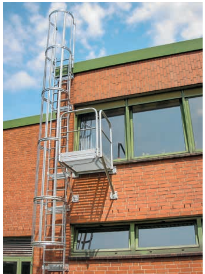
Egyszakaszos rögzített menekülő létrarendszer dobogóval.
